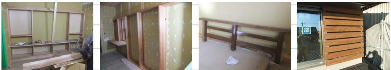
現場で大工さんが長さや幅、高さや仕口を加工し取付けます。その他技術のいる作業が多く、熟練工の必要がないハウスメーカー・ローコストのメーカーではできない仕事です。旧家の欄間も取付ました。何を取っても工務店ならではの住宅です。
